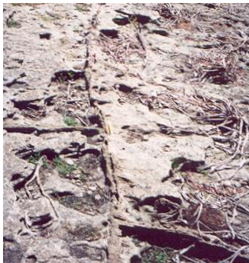
Figura. 4. 18b. Fraturas na direção paralela e perpendicular à costa, preenchidas por material carbonático.
