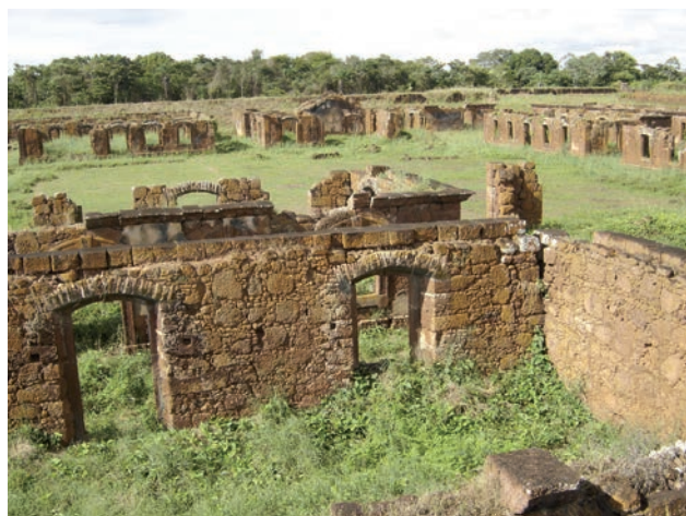
Figura 12.48 – Forte Príncipe da Beira, construído com blocos de laterito (marginal ao rio Guaporé, Costa Marques).
