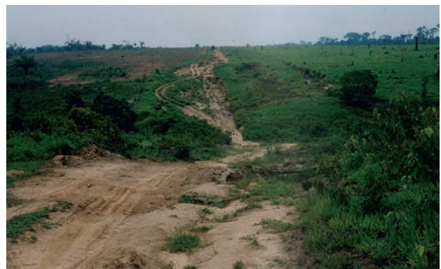
Figura 12.90 – Antiga estrada para usina de calcário, de ambiência favorável à formação de ravinas e voçorocas (próximo à cidade de Pimenta Bueno).
