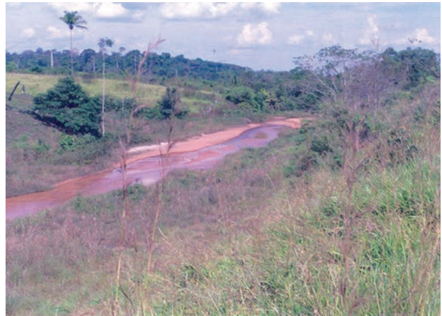
Figura 9.30 – Processo acelerado de assoreamento em área desmatada (rodovia RO-399).
