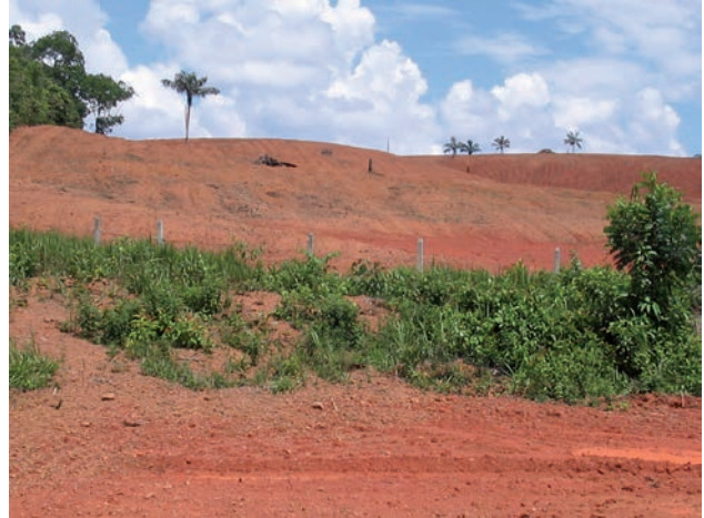
Figura 12.45 – Erosão laminar formando sulcos em solos lateríticos concrecionários em tabuleiros dissecados (rodovia BR-364, vila Jaci-Paraná).
