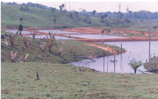
Figura 12.6 – Represamento de drenagens de pequeno porte para piscicultura (Ariquemes).
