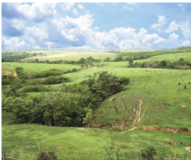
Figura 12.65 – Colinas amplas e suaves em arenitos Utiariti (rodovia BR-364).
