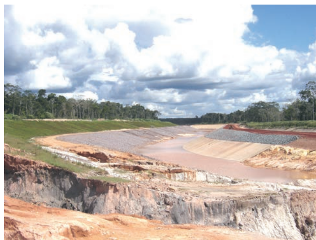
Figura 12.73 – Obras de implantação da UHE Rondon II (rio Comemoração, Pimenta Bueno).
