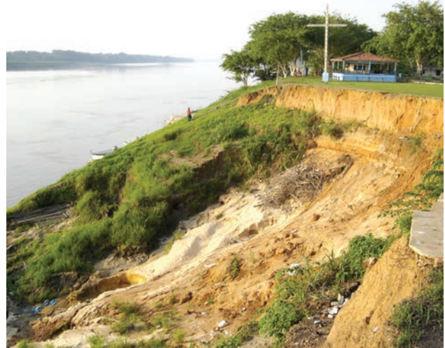
Figura 9.24 – Escorregamento de talude (vila Calama, baixo rio Madeira).
