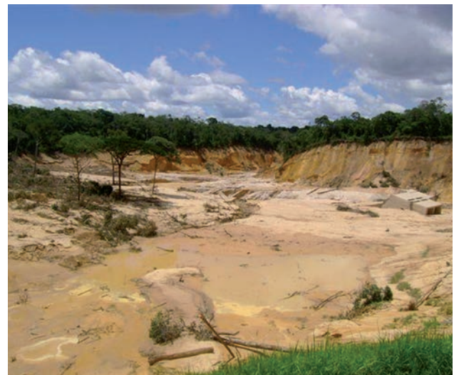
Figura 9.13 – Ruptura da barragem da PCH do rio Apertadinho (Vilhena). Fonte: Acervo fotográfico pessoal de Reinaldo Sure Soeiro (2008).
