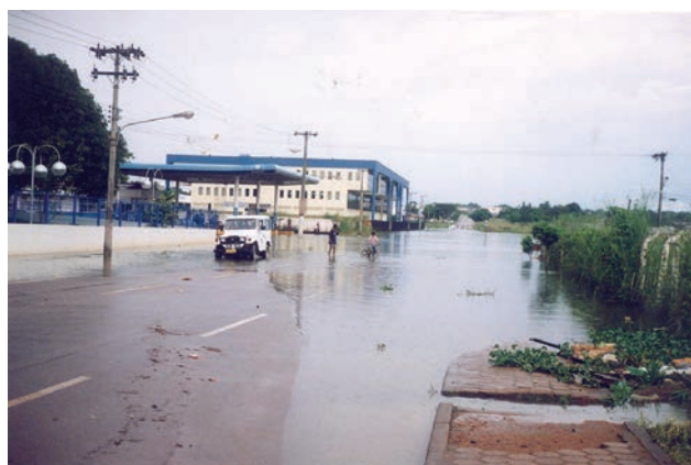
Figura 1.5 – Zona central de Porto Velho, submetida a inundação pela variação sazonal do rio Madeira.
