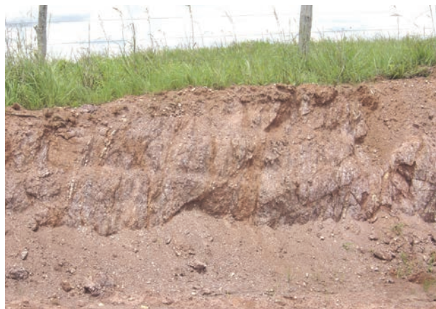
Figura 12.175 – Paragnaisses alterados (rodovia RO-399).
