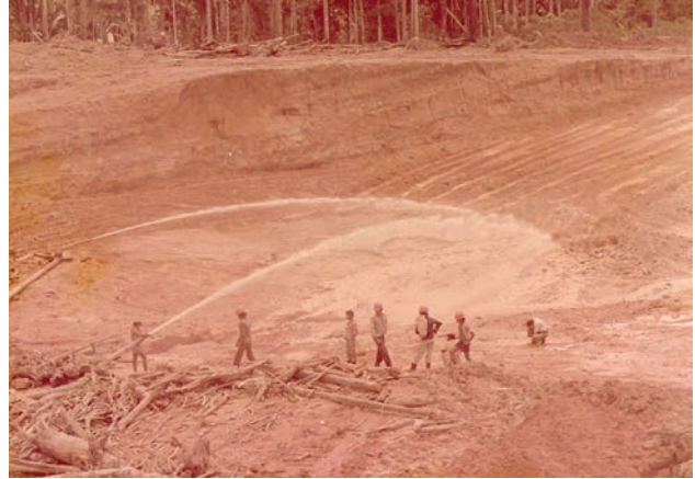
Figura 12.136 – Desmorte hidráulico em aluvião estanífera (mina São Lourenço, década de 1980).
