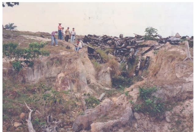
Figura 9.18 – Proteção rudimentar de voçorocas (Pimenta Bueno).
