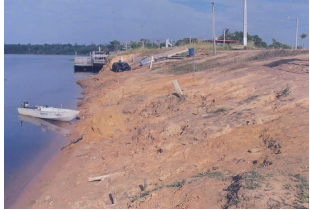
Figura 9.27 – Implantação de muro de arrimo em concreto no atracadouro principal (rio Guaporé, orla da cidade de Pimenteiras).
