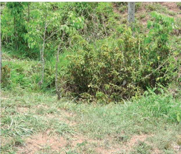
Figura 12.95 – Dolinas em arenitos carbonáticos (rodovia RO-267).
