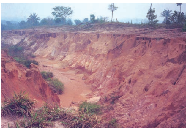
Figura 12.66 – Processo de voçorocamento na área marginal à rodovia RO-399, próximo a Vilhena.
