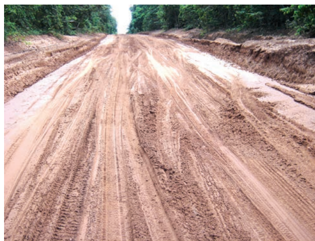
Figura 12.72 – Solos arenosos profundos; formação Fazenda Casa Branca (acesso à UHE Rondon II; BR-364, região de Pimenta Bueno).
