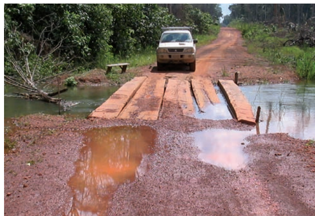
Figura 12.5 – Nível fluviométrico elevado, passível de inviabilizar o tráfego viário.
