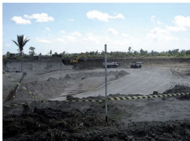
Figura 12.12 – Extração de argila para indústria cimenteira (rodovia BR-364, próximo a Candeias do Jamari).
