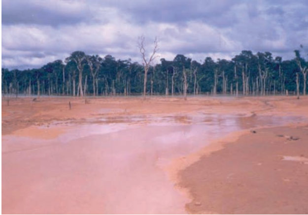
Figura 9.11 – Barragem da mina Bom Futuro rompida em 1998 (Ariquemes). Fonte: Carvalho Neto, 2006.
