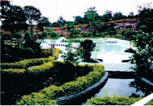
Figura 12.94 – Estação de captação de água subterrânea (empresa Lind'Água, Pimenta Bueno).
