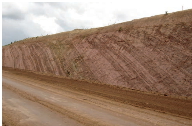
Figura 12.156 – Corte de estrada com ritmitos, de coloração variegada, da formação Terra Boa (rodovia BR-429, próximo à vila Terra Boa).
