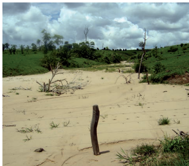
Figura 12.60 – Assoreamento de drenagem pela erosão de arenitos Utiariti (rodovia do Progresso).
