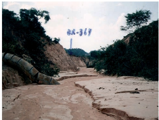
Figura 9.17 – Antigo traçado da rodovia BR-364 afetado por ampla voçoroca (vila Guaporé).
