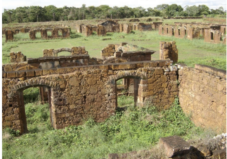
Figura 10.53 – Antiga fortificação construída com blocos de laterito colunar (Forte Príncipe da Beira, junto ao rio Guaporé).
