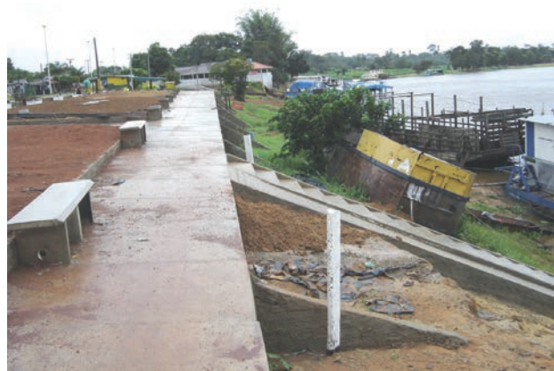
Figura 12.24 – Estrutura de proteção contra a vigorosa erosão fluvial do rio Guaporé (Pimenteiras do Oeste).
