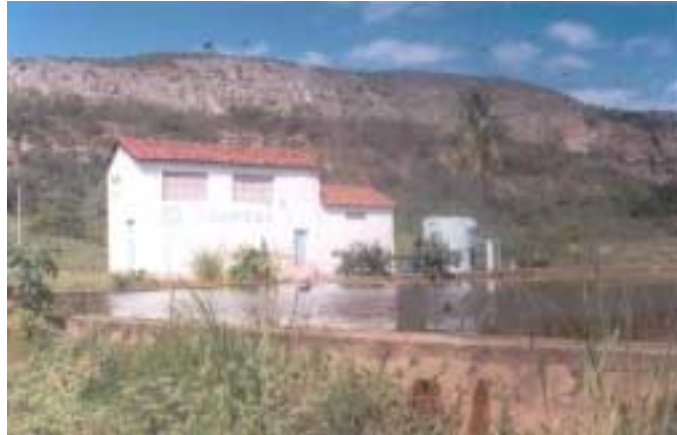
Foto 5 – Estação de tratamento químico (COMPESA) das águas com alto teor de ferro, captadas por uma bateria de poços na Fazenda Brejo de São José, perfurados na seção basal da Formação Tacaratu.
