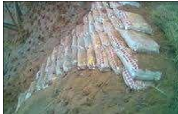
Detalhe do muro de sacos de solo-cimento: os sacos são empilhados junto ao talude (barranco) para prevenir escorregamentos e recompor sulco provocado pela erosão na encosta.
