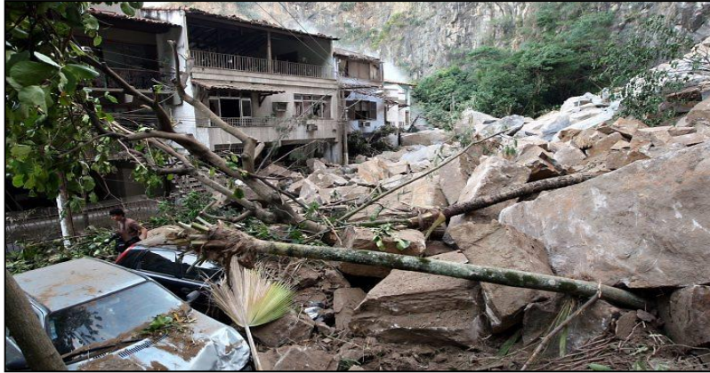
Em junho de 2009, blocos de rocha de uma antiga pedra rolaram da encosta e atingiram um condomínio em Vila Isabel, no Rio de Janeiro (RJ).
