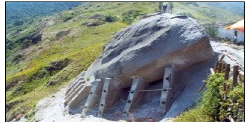
Escoramento de bloco de rocha que ameaça rolar pela encosta.
