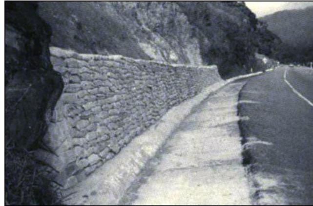
Muro de sacos de cimento misturado com solo.
