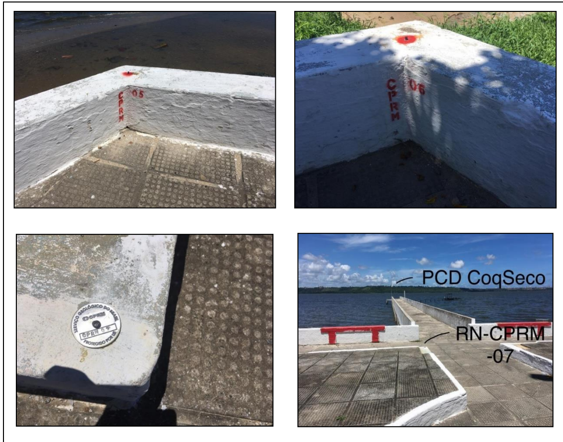
Figura 10. Estação PCD localizada em Coqueiro Seco sendo os RNs (RN-CPRM-05, RN-CPRM-06 e RN-CPRM-07) rastreados por GPS geodésico e o nivelamento do sensor do radar da PCD.
