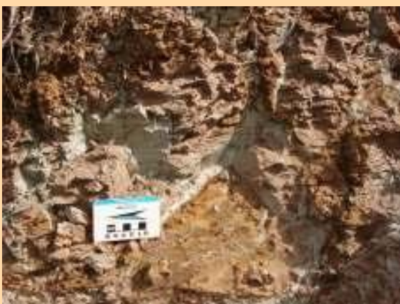
Fotografia 06: Contato entre siltito castanho amarelado e argilito cinza em corte de estrada próximo da terceira ponte, destacando padrão de fraturamento.
