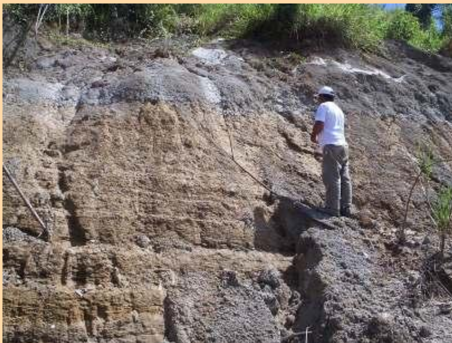
Fotografia 09: Argila cinza com veios de brushite (material branco no topo) sobreposto ao argilitos laminados da Formação Solimões. Panorama, Rio Acre.
