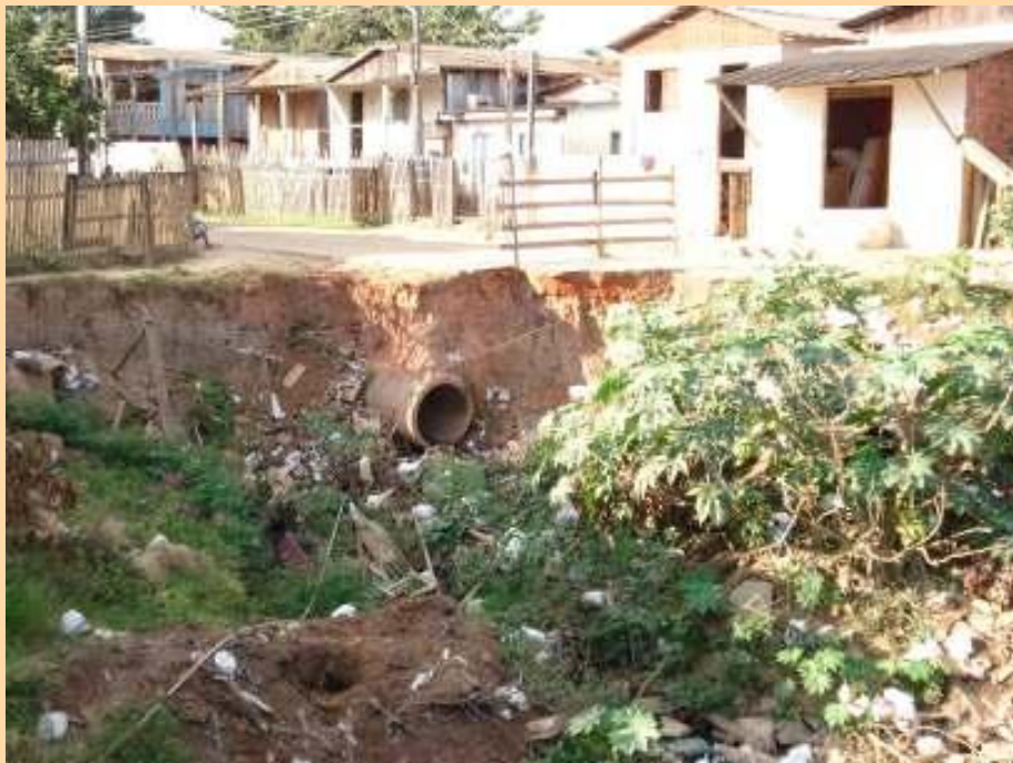
Fotografia 19: Voçoroca no Bairro Cidade Nova, margem do rio Acre. O lançamento das águas pluviais sobre terreno arenoso desencadeou o fenômeno erosivo. Detalhe das péssimas condições de saneamento do local.
