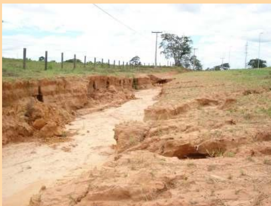
Fotografia 18: Erosão em solo arenoso, obra de abertura do anel viário, localidade do Amapá, AL-07.
