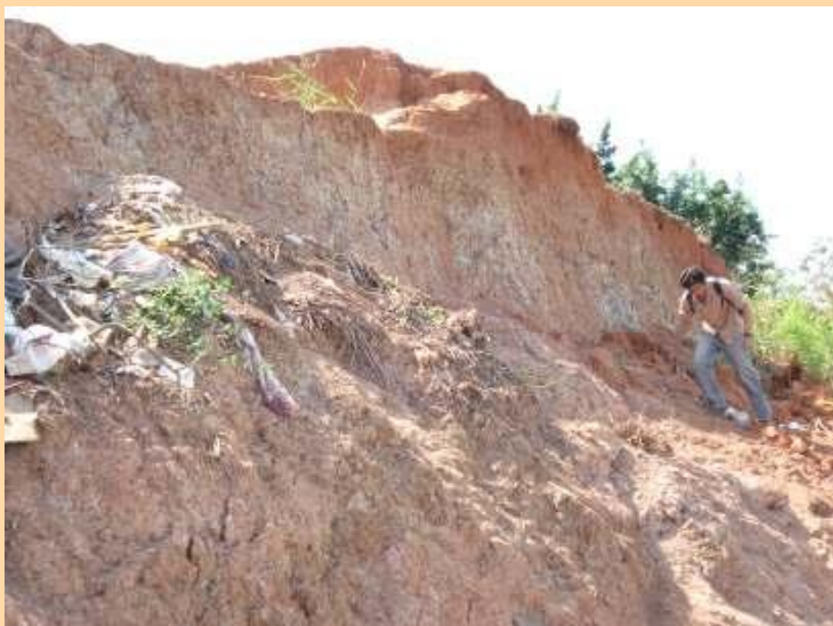
Fotografia 14: Deslizamento no topo da encosta mais elevada do bairro Papoco. Argila mosqueada de cor vermelha amarelada. Detalhe da disposição de lixo irregular na encosta
