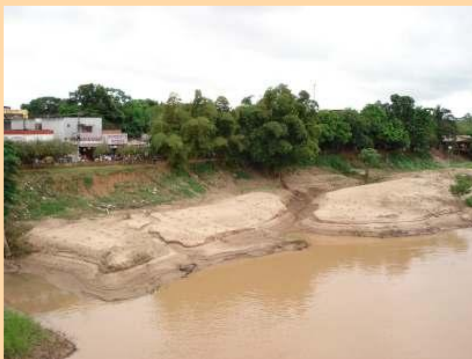
Fotografia 11: Banco de areia depositado na calha do rio Acre junto à ponte no centro de Rio Branco.
