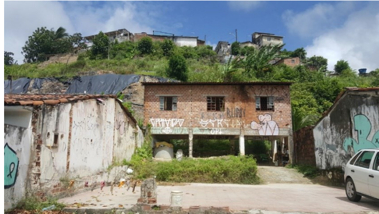
Figura 23. Local onde se situava a igreja, destruída pelo deslizamento ocorrido em 28/06/2011.
