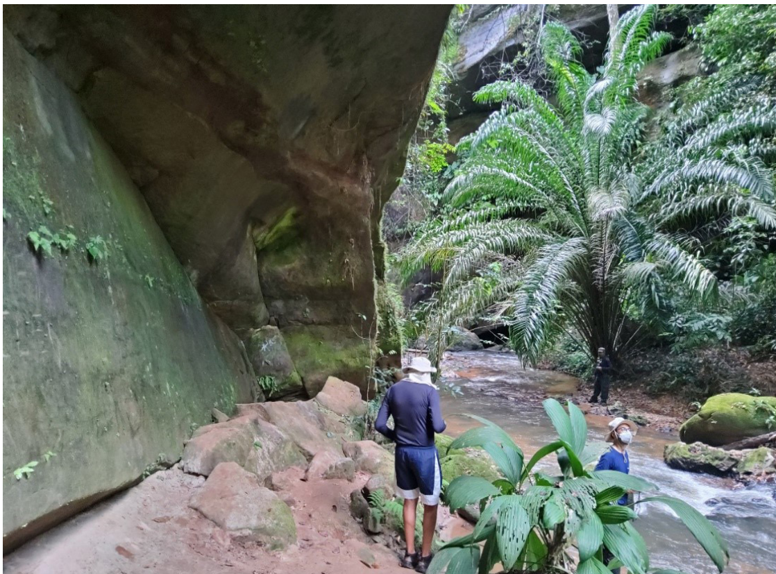
Figura 45 - Porção de declividade negativa do maciço rochoso, formada pela interseção entre estratificações de baixo ângulo e fratura subvertical pervasiva.
