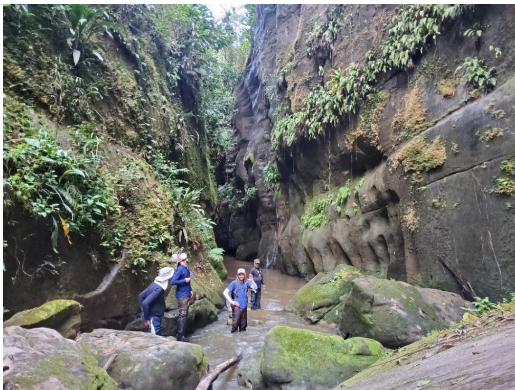
Figura 16 - Avaliação geológico-geotécnica das escarpas do cânion do rio Peraúna.
