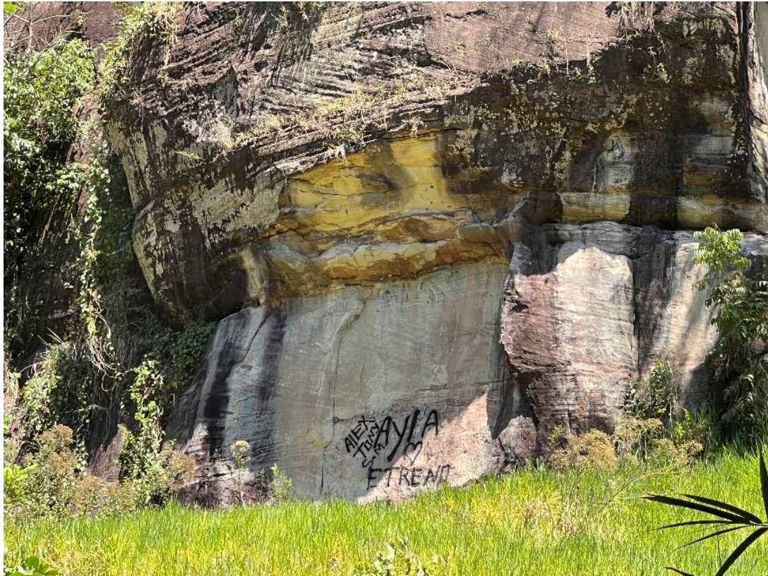
Figura 20 - Pichações nas exposições areníticas do cânion do rio Sergi. Notar cicatriz de recente deslocamento de rocha na porção do maciço com declividade negativa.
