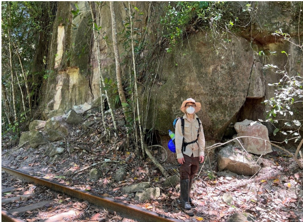
Figura 59 - Queda de blocos de rocha recentemente ocorrida em escarpa localizada a poucos metros da Ferrovia Centro Atlântica, em local de alta circulação de turistas.
