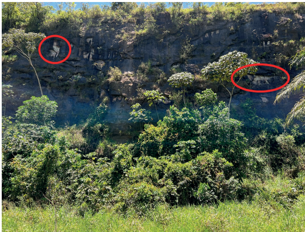
Figura 39 - Cicatrizes na escarpa esquerda do cânion do rio Sergi, nas imediações da Cachoeira Pingadeira, evidenciando processos de queda de blocos ocorridos recentemente no local. Detalhes na figura 40.
