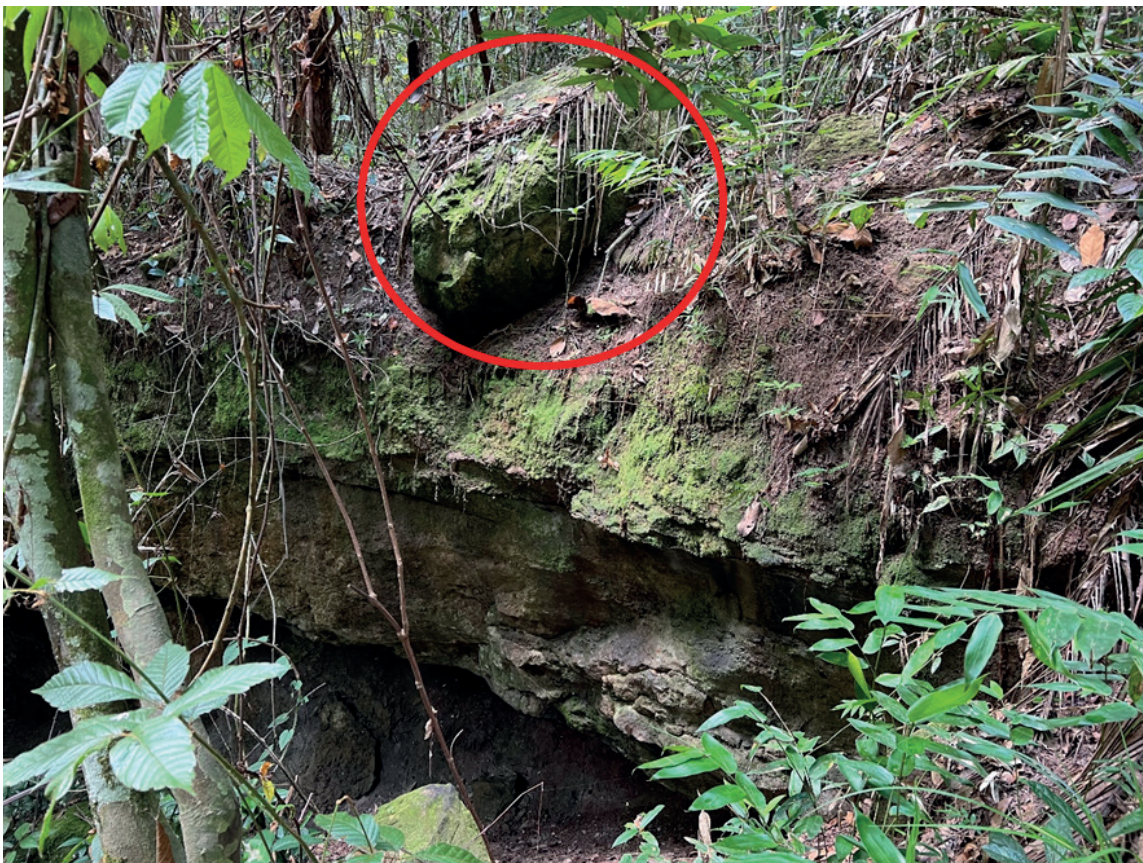
Figura 32 - Bloco solto sobre plano inclinado.
