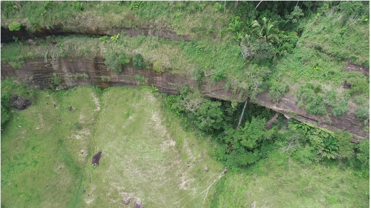
Figura 28 - Vista aérea da Cachoeira do Lobo. Notar blocos de rocha emersos nos depósitos de tálus localizados na base da escarpa.
