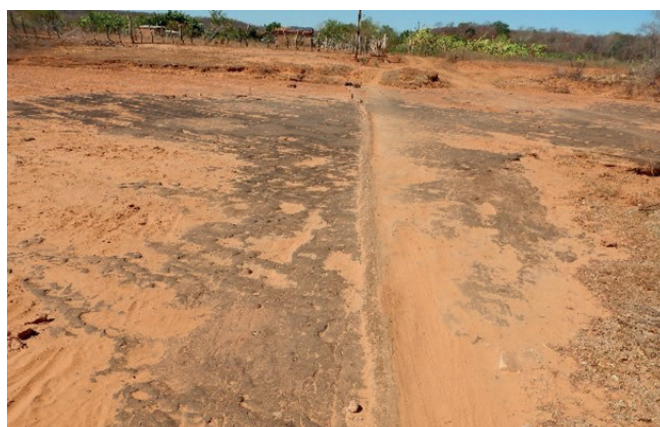
FIGURA 8 – Acima, fundação de uma cerca construída sobre o pavimento. Abaixo, instalação de cano para transporte de água. Fonte: arquivo dos autores.
