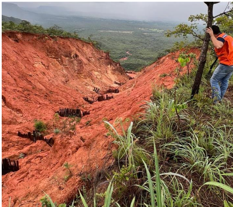
Figura 15: Paliçadas instaladas no interior da feição erosiva 1. Fonte: foto dos autores.
