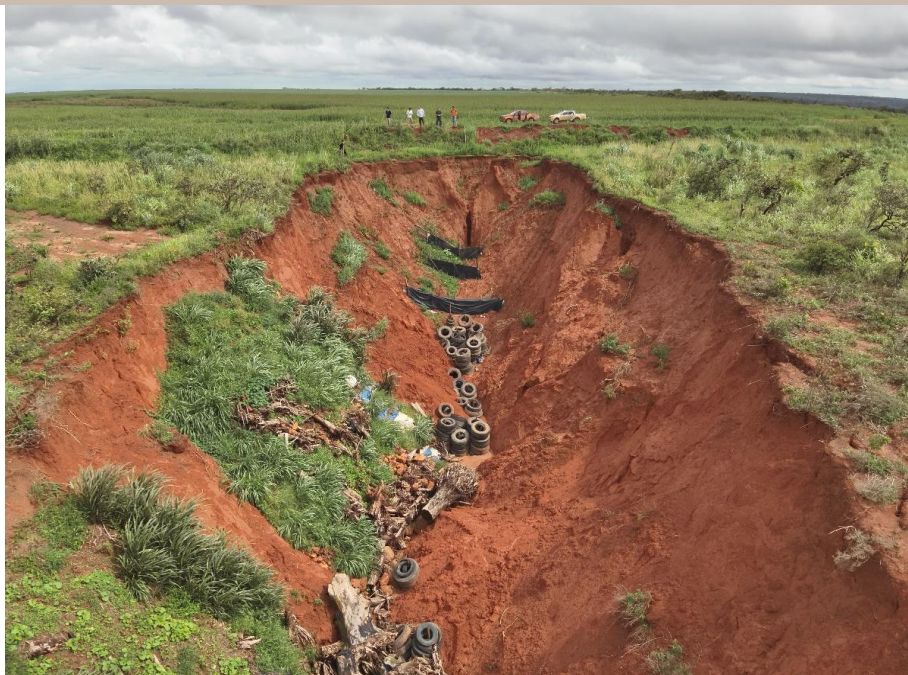
Figura 19: Foto panorâmica da feição erosiva 2, obtida por drone. Notar barreiras de geotêxtil, além de lixo e entulho depositado no interior da erosão. Fonte: foto dos autores.
