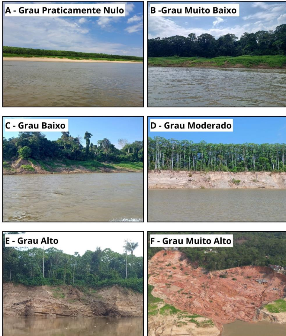
Figura 07: Tipologia de graus de suscetibilidade à erosão fluvial e recuo de barrancas aqui proposto. Fonte: figuras a, b, c, d, e (Autores). Figura f (CB BM Assunção).
