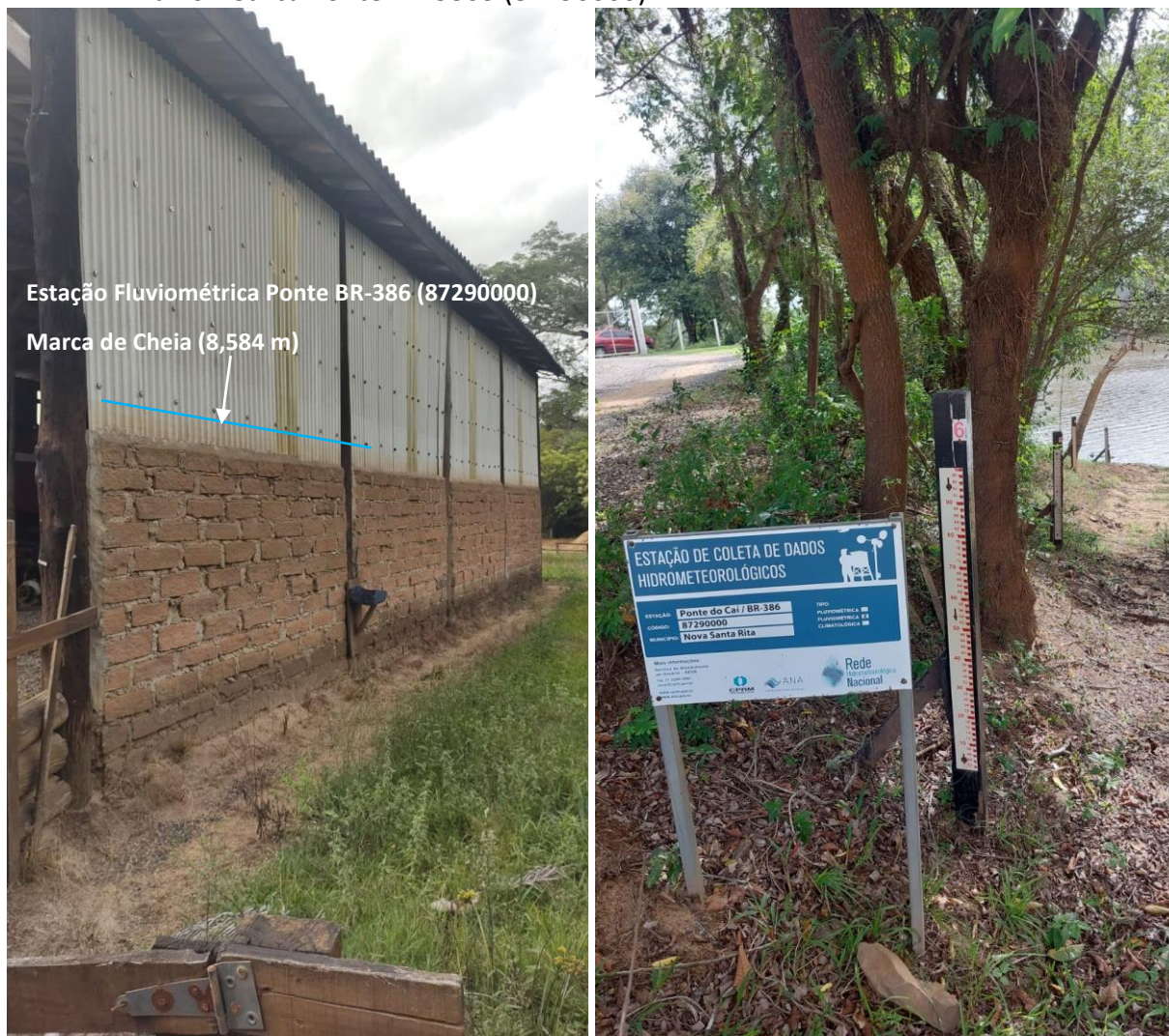
Figura 16. Marca de cheia (8,584 m) nivelada do rio Caí, no município de Nova Santa Rita / RS, na região metropolitana da capital Porto Alegre / RS, referente a estação fluviométrica Ponte BR-3863 (87290000).
