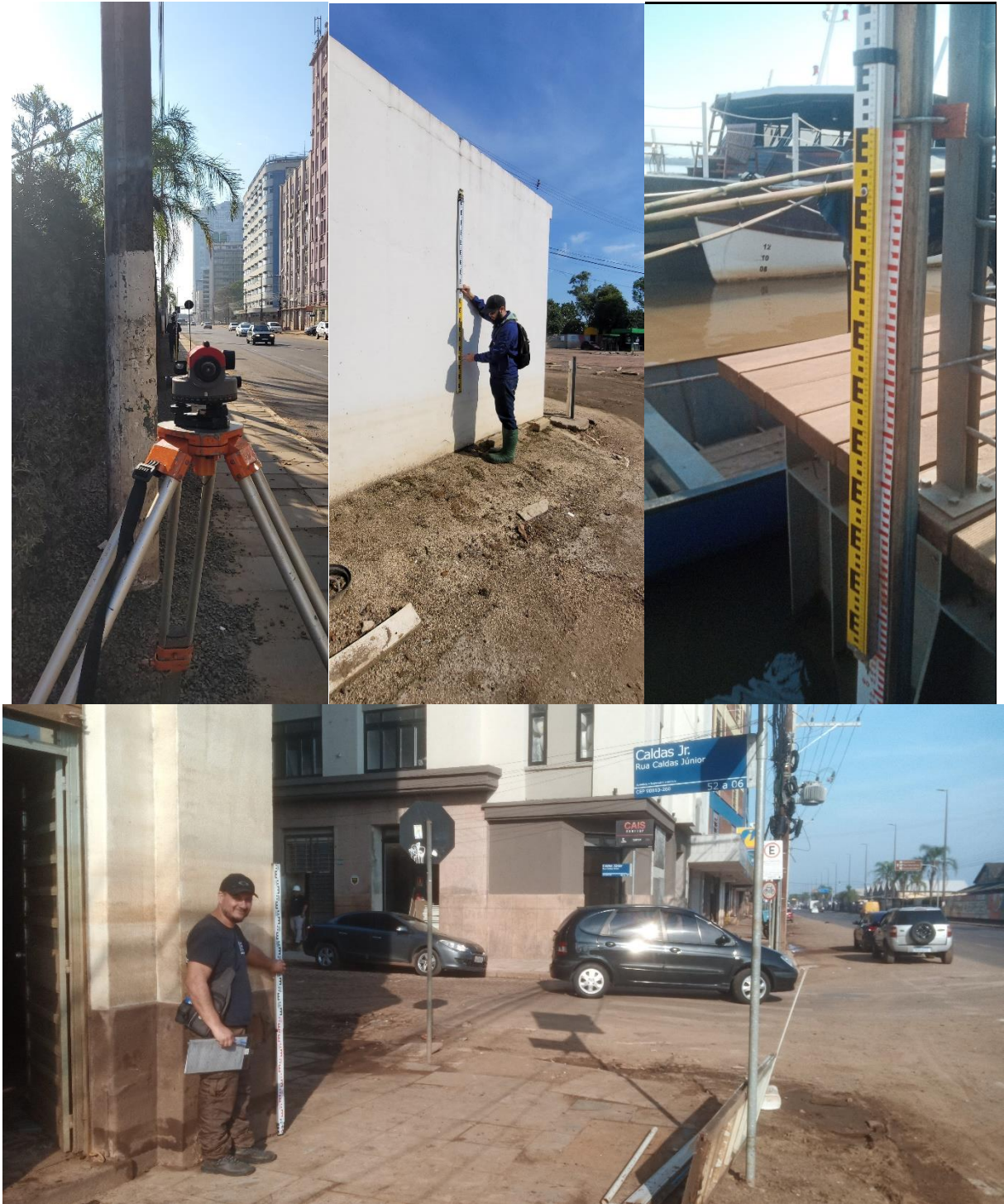
Figura 15. Trabalho de levantamento das marcas de cheia niveladas do rio Jacuí, na capital Porto Alegre / RS, referente as estações fluviométricas Caís Mauá C6 e Usina do Gasômetro.
