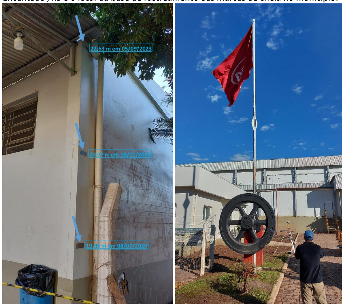
Figura 7. Locais das marcas de cheia de 08/07/2020, 05/09/2023 e 18/11/2023, no frigorífico em Encantado /RS e o local da base de rastreamento das marcas de cheia no município.
