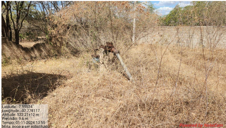
Figura 7: Poço P03-CS/FL/SN abandonado e abstruído
