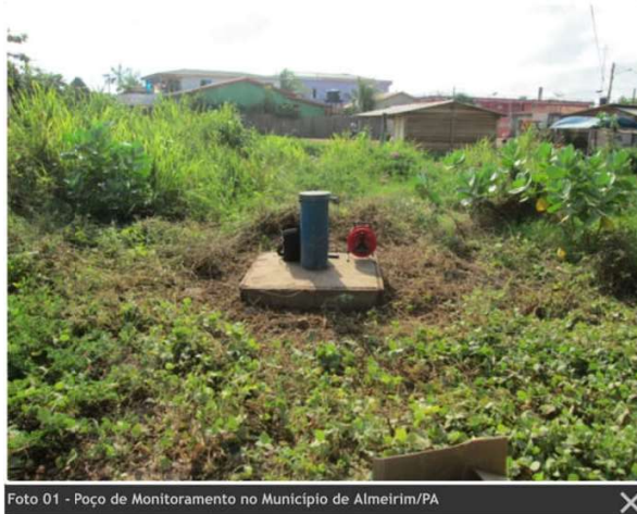
Foto 01 - Poço de Monitoramento no Município de Almeirim/PA
