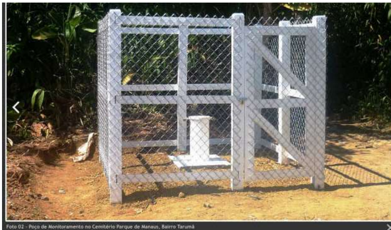
Foto 02 - Poço de Monitoramento no Cemitério Parque de Mênasis, Bairro Tarumã
