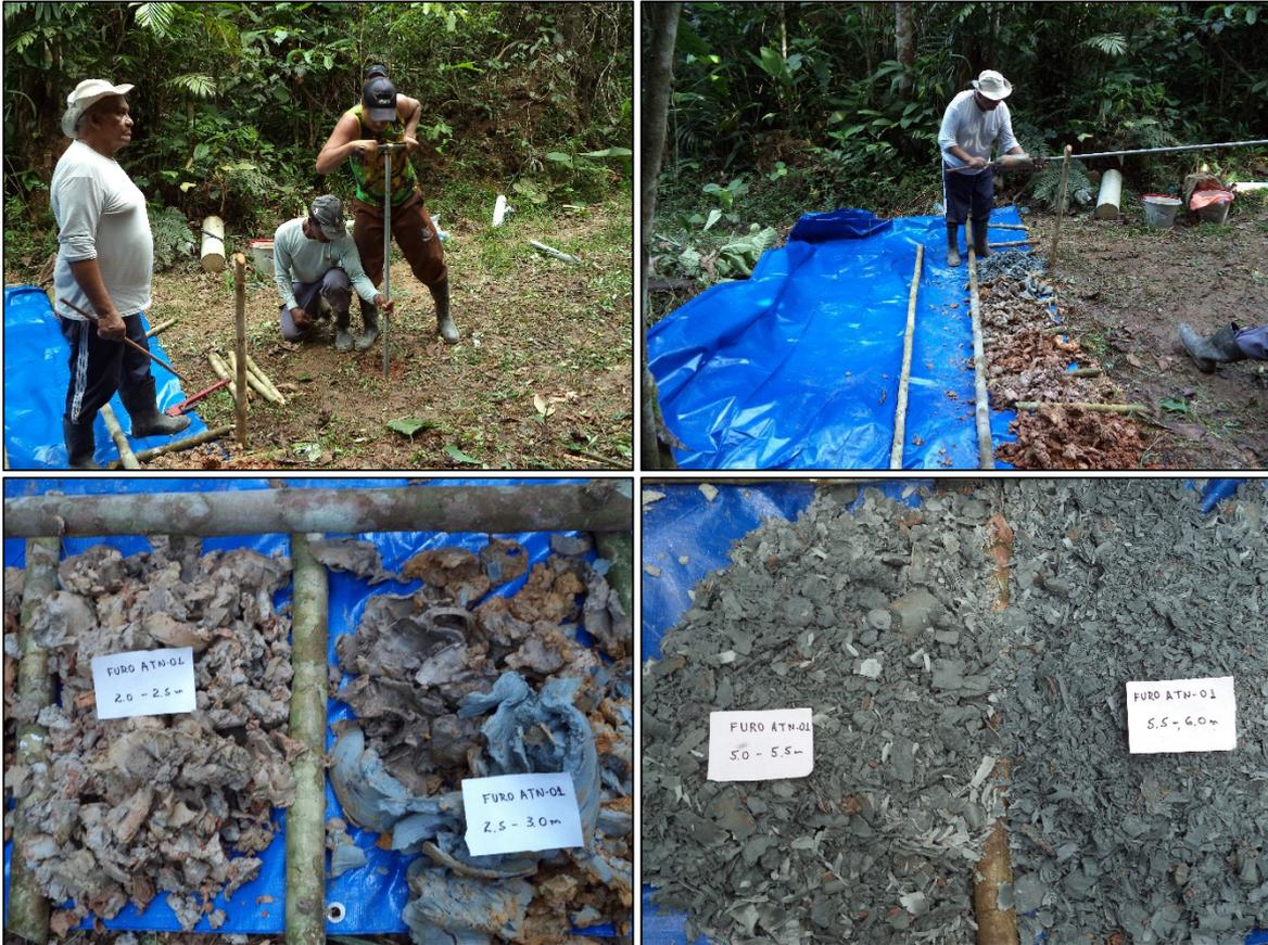
**Figura 9:** Aspectos da perfuração e dos solos argilosos atravessados em dois intervalos do furo ATN-01.
