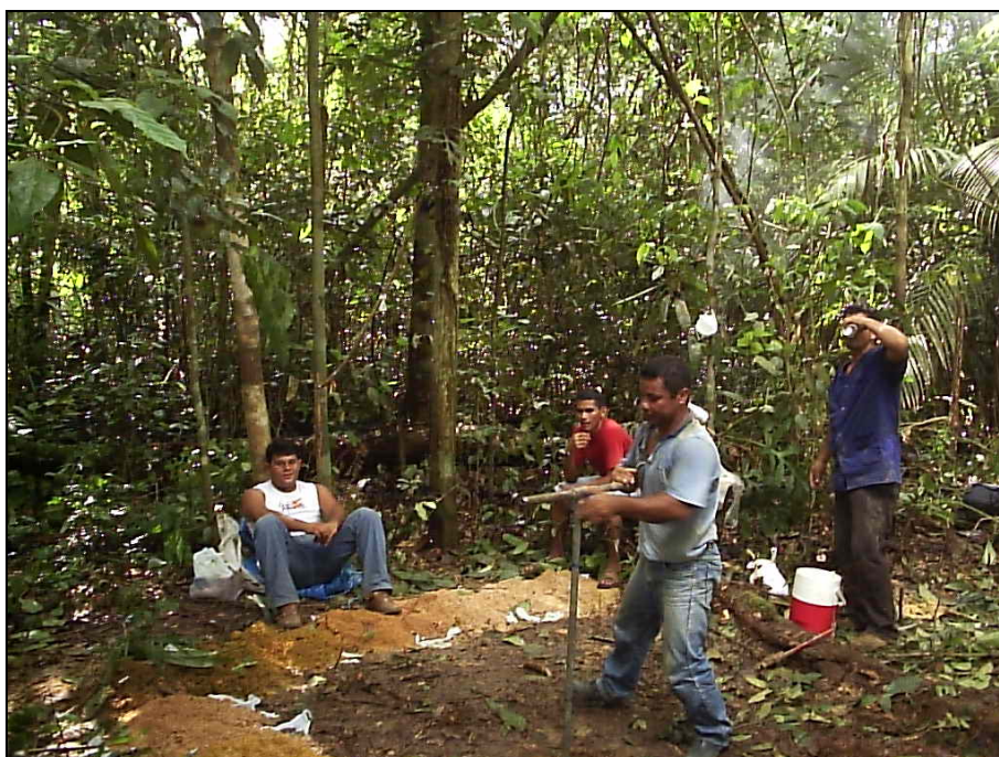
Foto 4: Furo de trado IR-02, no interior da floresta nativa existente no terreno do futuro aterro sanitário.
