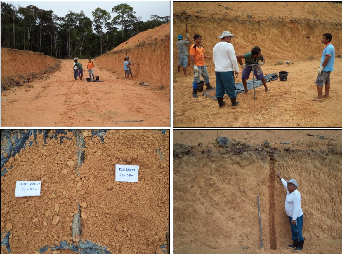
**Figura 11:** Perfuração do furo RPE-04, no fundo de vala do aterro provisório; aspecto do solo silto-argiloso atravessado pelo último metro desse furo; e vista da canaleta de amostragem da parede da vala.
