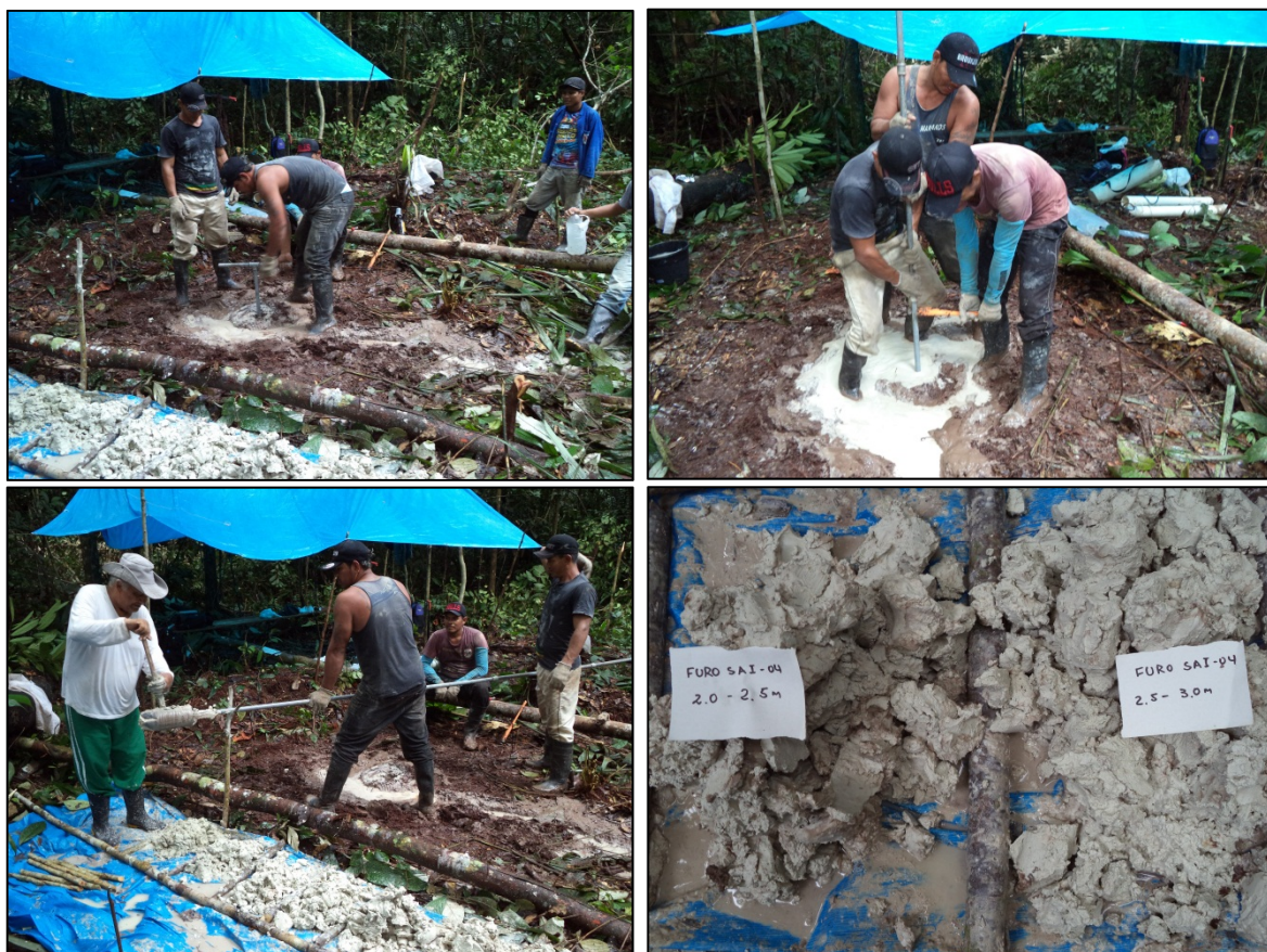
Figura 11: Aspectos da perfuração e do solo argilo-arenoso atravessado pelo furo SAI-04.
