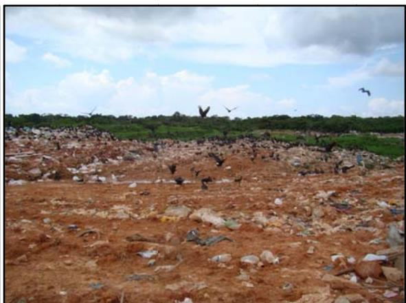
Figura 2: Fotos panorâmicas e de detalhe do atual aterro controlado de Tefé com destaque para o lixo ainda sem cobertura de argila e a conseqüente proliferação de urubus na área.
