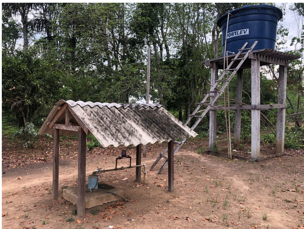
Figura 5: Poço escavado na Aldeia Figueira. Fonte: Foto tirada pelos autores.
