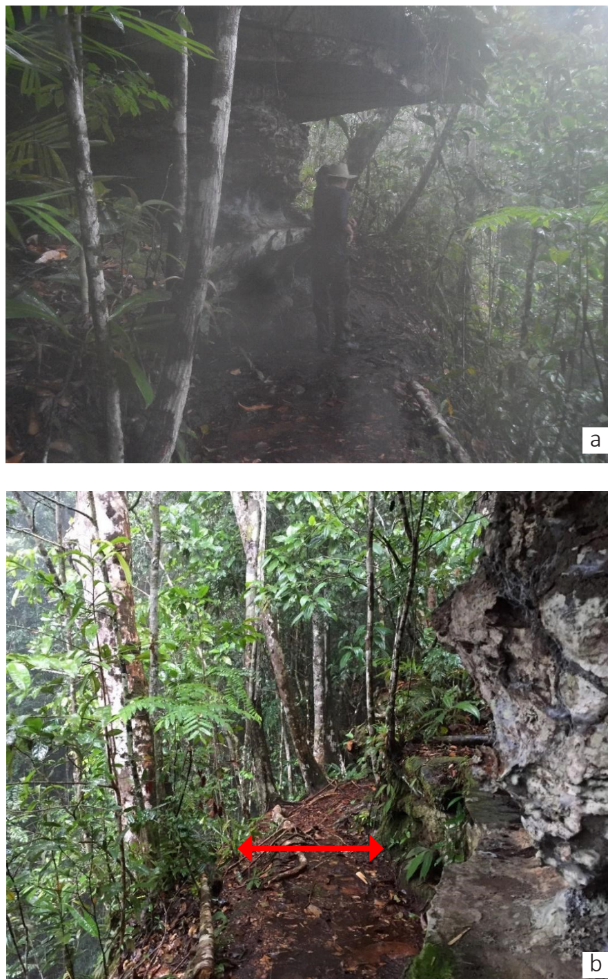
Figura 31 - Salto do Ipy. Feição da erosão diferencial com blocos de rocha sustentado em pequenos promontórios (a). Nota-se trilha de acesso estreita, com 1 metro de largura (seta vermelha) entre a rocha e a escarpa íngreme (b). Risco de queda do visitante.
