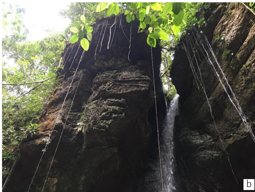
Figura 16 - Gruta da Judéia. Risco alto de queda de bloco da parte superior da gruta (a – seta vermelha). Notar a ação da água erodindo o maciço (b). Recomenda-se a sinalização de perigo e restrição de acesso na parte abaixo do bloco.
