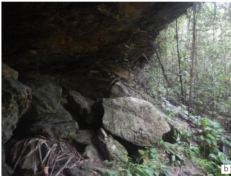
Figura 33 - Gruta do Batismo. Escarpa rochosa com erosão diferencial formando relevo negativo (a). Notar os blocos de rocha caídos na base da escarpa. Alto risco de queda de blocos. Recomenda-se a sinalização e afastamento lateral da trilha de acesso (seta vermelha).
