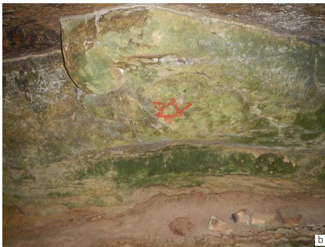
Figura 34 - Gruta do Batismo. Teto da gruta com pinturas rupestres. Notar o deslocamento da rocha (a) e pichação do sítio arqueológico (b).
