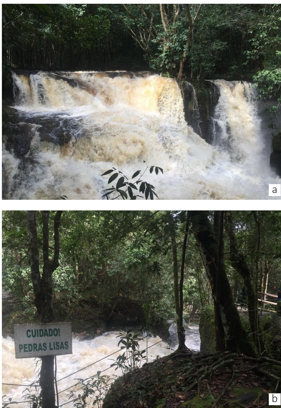
Figura 20 - Cachoeira do Santuário. Notar grande volume de água e escarpa íngreme. Risco de queda para o visitante. Recomenda-se sinalização de perigo e reforço na proteção lateral da escarpa (a e b).
