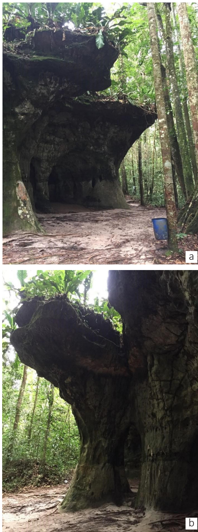
Figura 06 - Parede dos Arcos, na trilha de acesso à cachoeira da Iracema. Erosão diferencial formando cornijas (ressaltos) na parte superior e cavidades na base do paredão. Risco de queda de blocos (a e b).
