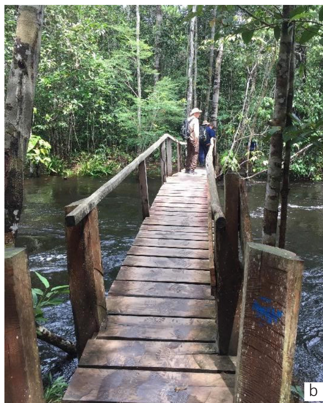
Figura 29 - Cachoeira do Mutum. Nota-se grande vazão (a) e ponte sobre o igarapé do Barreto, com guarda corpo vazado, e risco de queda do visitante (b).
