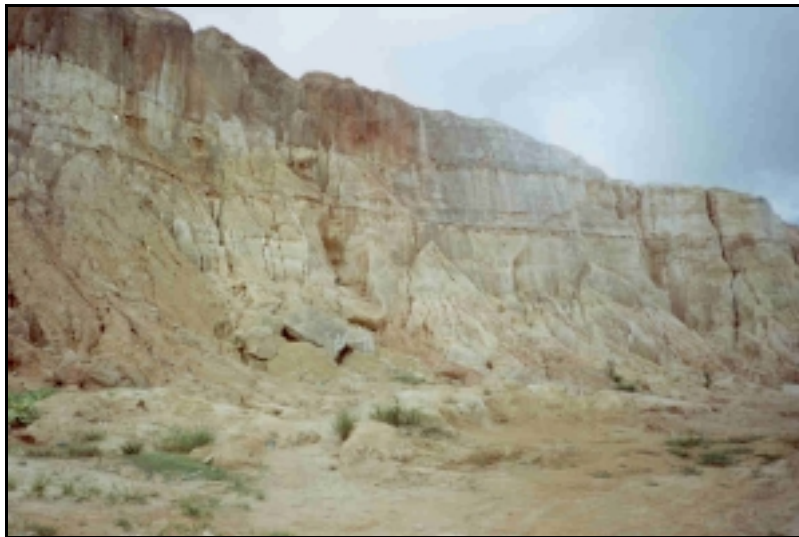
Foto 6.8 – Erosão e desmoronamento em área desativada de extração de argila
