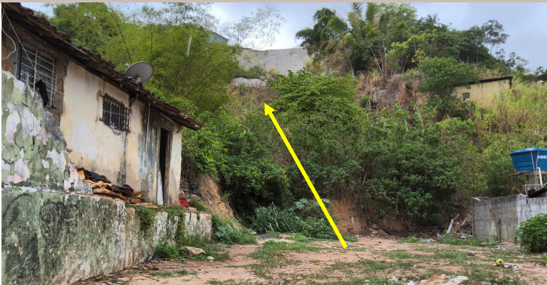
Figura 2 – Área onde ocorreu a destruição de uma residência em 2022, localizada na porção central do setor PE_CAMARAG_SR_026_CPRM, durante evento de deslizamento. Observa-se a presença de tela argamassada protegendo parte da área afetada, bem como residências desocupadas após o incidente.
